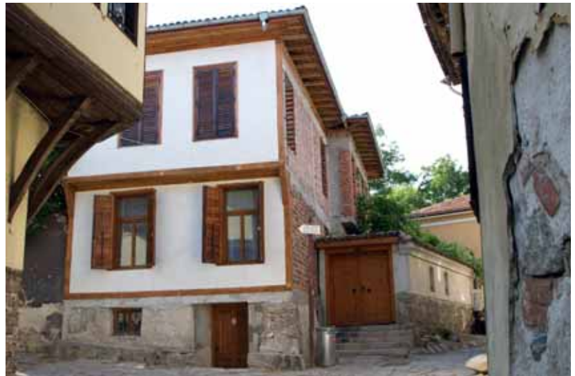
Abbildung 6: Haus fertig, fast ganz verputzt (2009)
