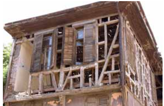
Abbildung 4: Vorbereitung zur Renovierung? (2006)
