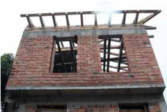
Abbildung 5: Neubau mit Beton und Ziegeln (2007)
